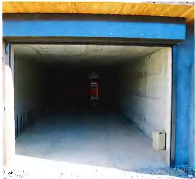
Stockage service des pistes
