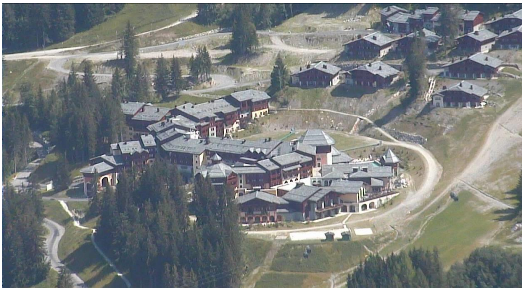
Photo 11 : Vue aérienne sur le Club Med de Valmorel Source : Office de tourisme
