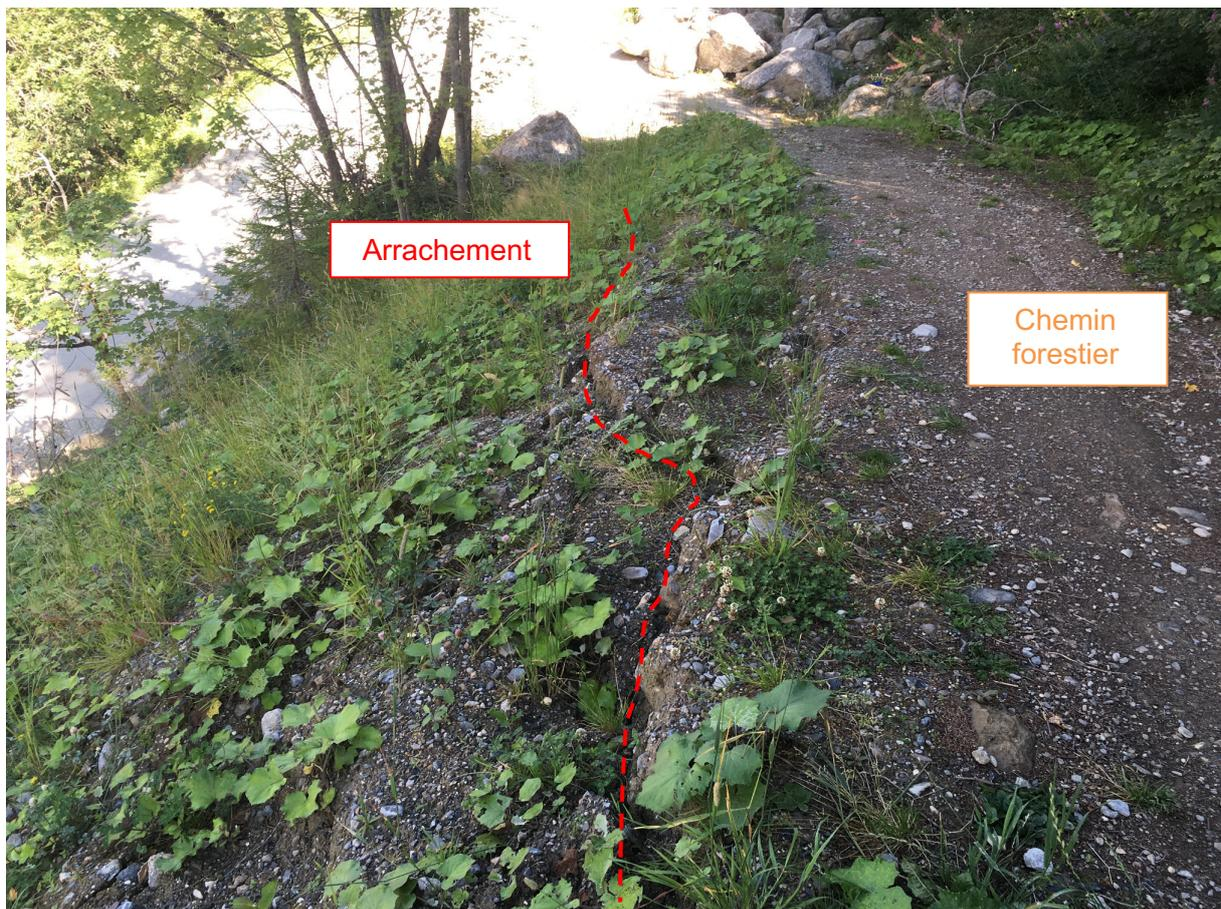
Cet arrachement est très probablement lié à la mise en œuvre de remblais de mauvaise qualité (*présence de débris de tuyaux, etc*), peu voire pas compactés dans cette zone et dans des pentes fortes (*de l'ordre de 48° dans ce secteur*).
